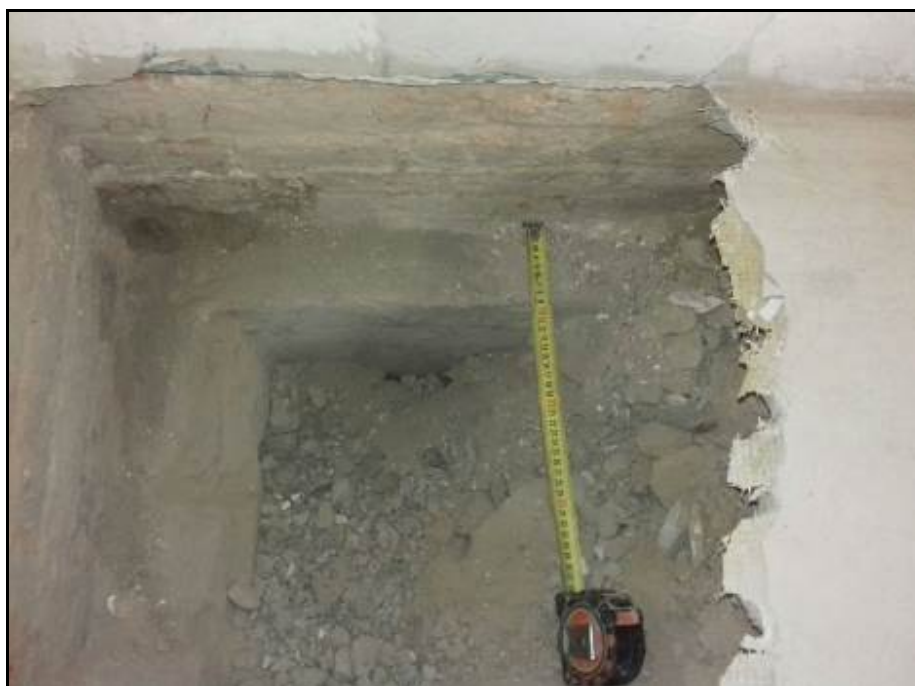
Fotografia 2: Cala 1, fins a trobar sabata de fonamentació.
