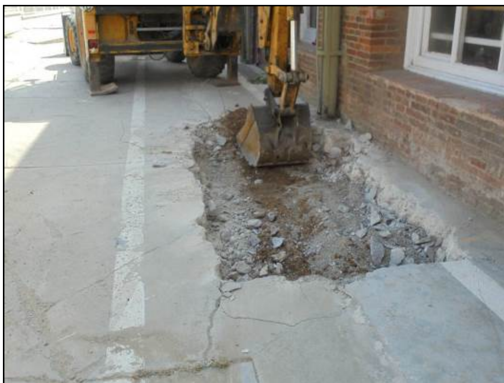
Fotografia 6: Cala 5, trencament paviment.
