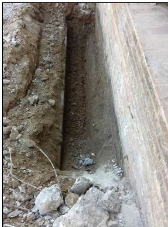
Fotografia 9: Cala 6, inici de fonamentació del mur exterior.
