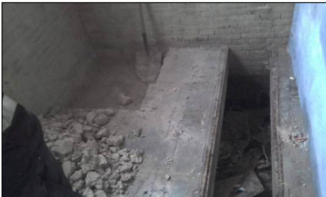
Fotografia 5: Cala 4 a l'interior, interrompuda per la presència d'un soterrani.
