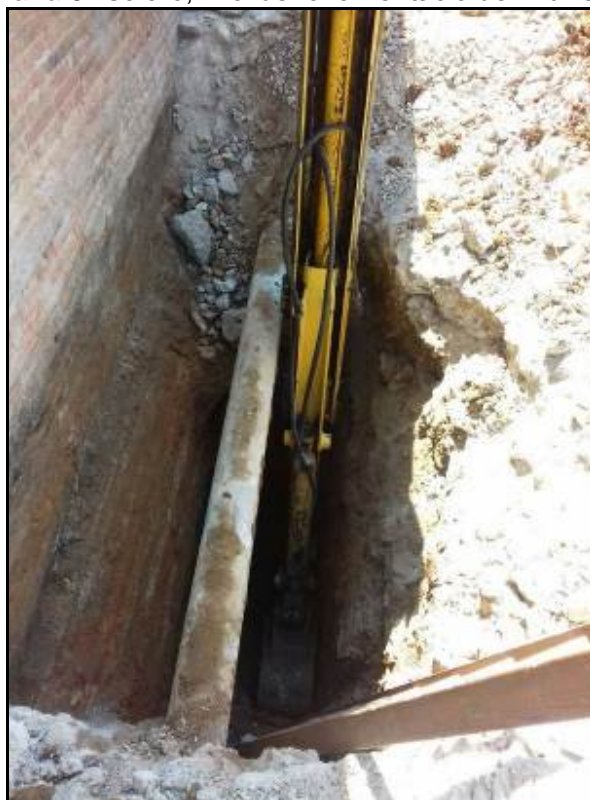
Fotografia 10: Cala 6, excavació de la cala fins els 4 m de fondària.
