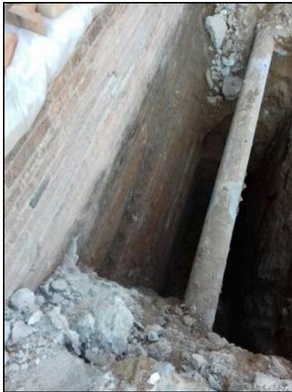
Fotografia 11: Cala 6, finalització de la cala.
